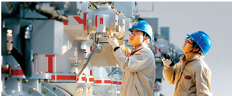
第300座主电网变电站投运前，电力工人在做最后的检查工作。（王慕宾 徐展新 摄）
