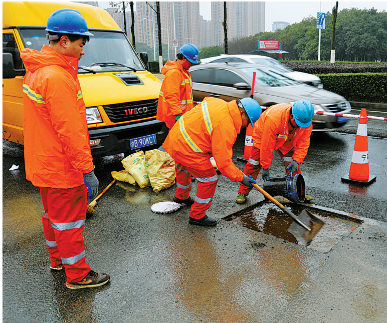
图为冷补丁施工现场。
