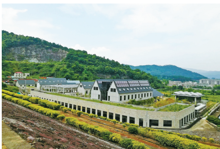
由旧厂房改造而成的宁波半山伴水旅游度假区一期项目开放在即。(陈朝霞 摄)
