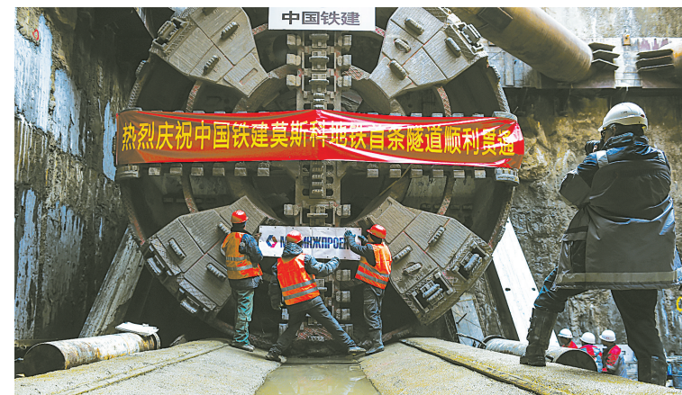
这是4月5日在俄罗斯首都莫斯科米丘林大街地铁站施工现场拍摄的贯通隧道的盾构机。当日，由中国铁建股份有限公司（中国铁建）承建的莫斯科地铁第三换乘环线维尔纳茨基大街站至米丘林站右线隧道贯通。这条隧道是中国企业在俄罗斯承建的第一条地铁隧道。（新华社发）
