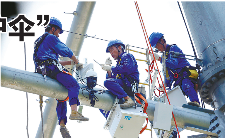
电力工人在跨高速铁路输电线路路上安装在线视频监测装置。 (王幕宾 徐展新 摄)
