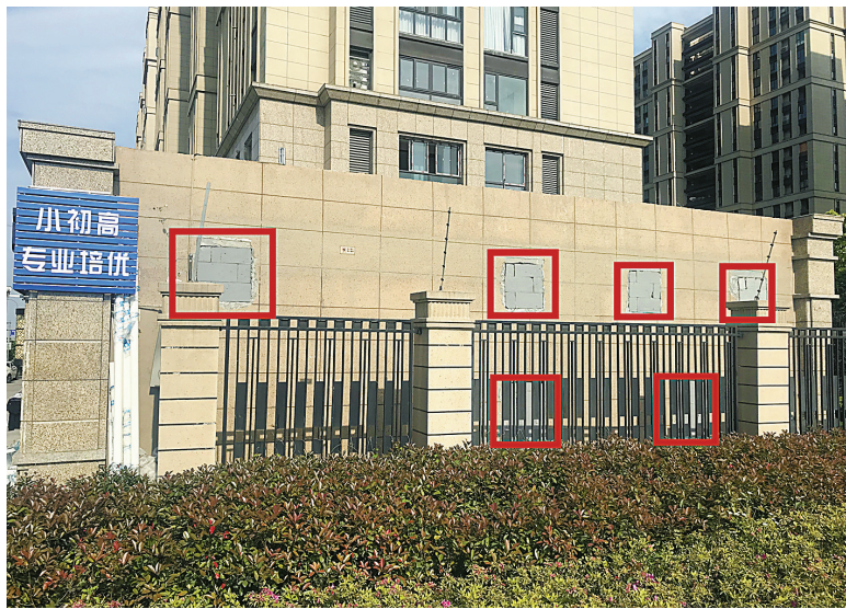
“逸学堂教育”店面房西侧墙大洞已封闭。(廖业强 摄)
