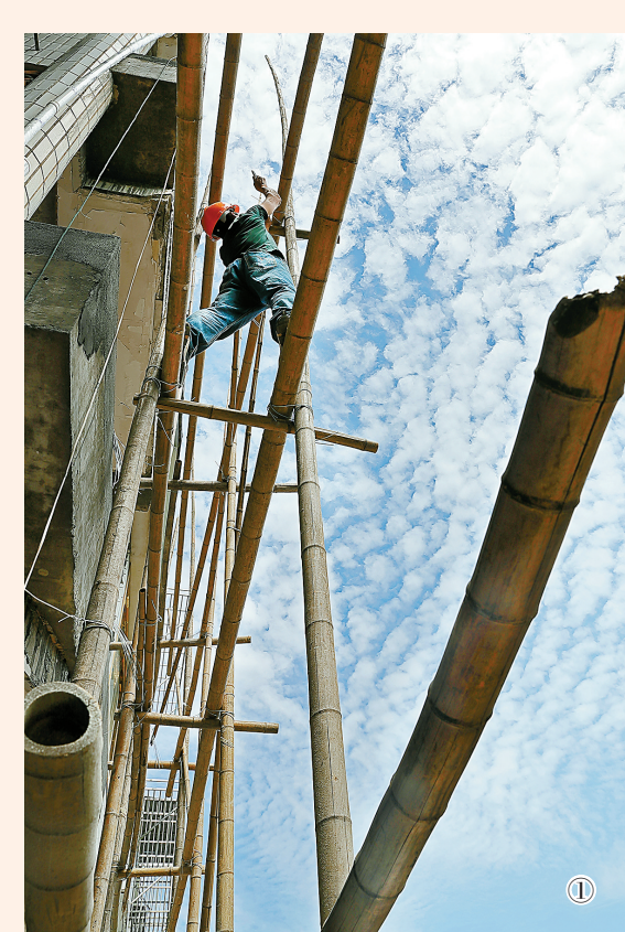
①架子工正在搭毛竹“鹰架”。 ②四明山区的农户用简易机器劈取“百篾”。 ③牢固的钢管配实惠的“竹片”，是当今建筑业的普遍选择。
