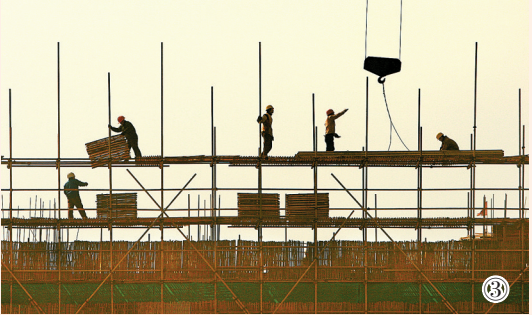
①架子工正在搭毛竹“鹰架”。 ②四明山区的农户用简易机器劈取“百篾”。 ③牢固的钢管配实惠的“竹片”，是当今建筑业的普遍选择。
