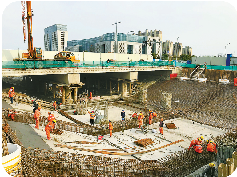
轨道交通3号线一期抗浮板施工。
