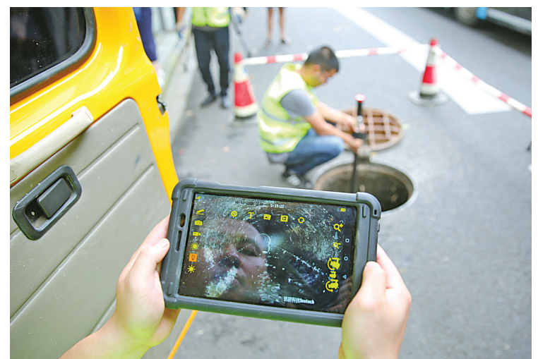
工人正在为排水管网“体检”。(宁波市供水排水集团供图)
