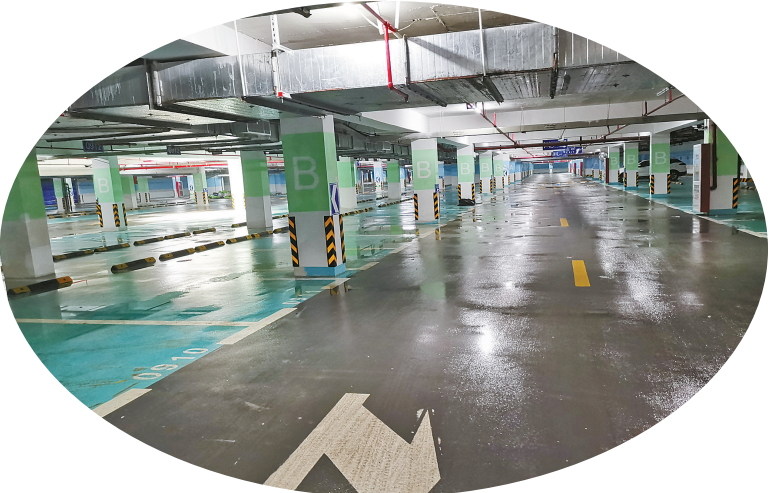
图为吾悦广场三期地下室。（陈结生 摄）
