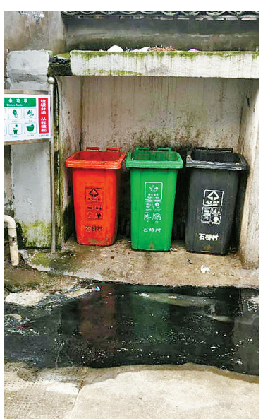
不断有污水冒出,地面低洼区囤积了一摊黑色的污水。(傅仲楠 摄)
