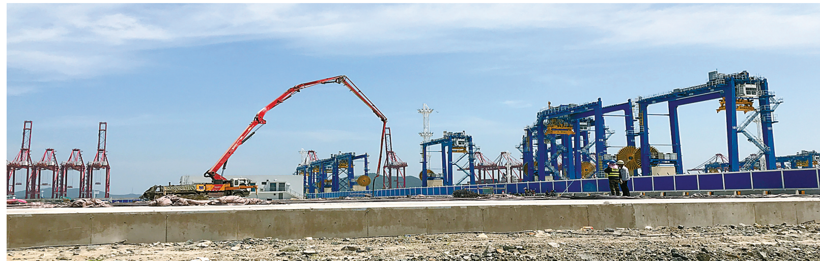
梅山港区7号堆场正在火热建设中，预计8月底完工。（俞永均 摄）
