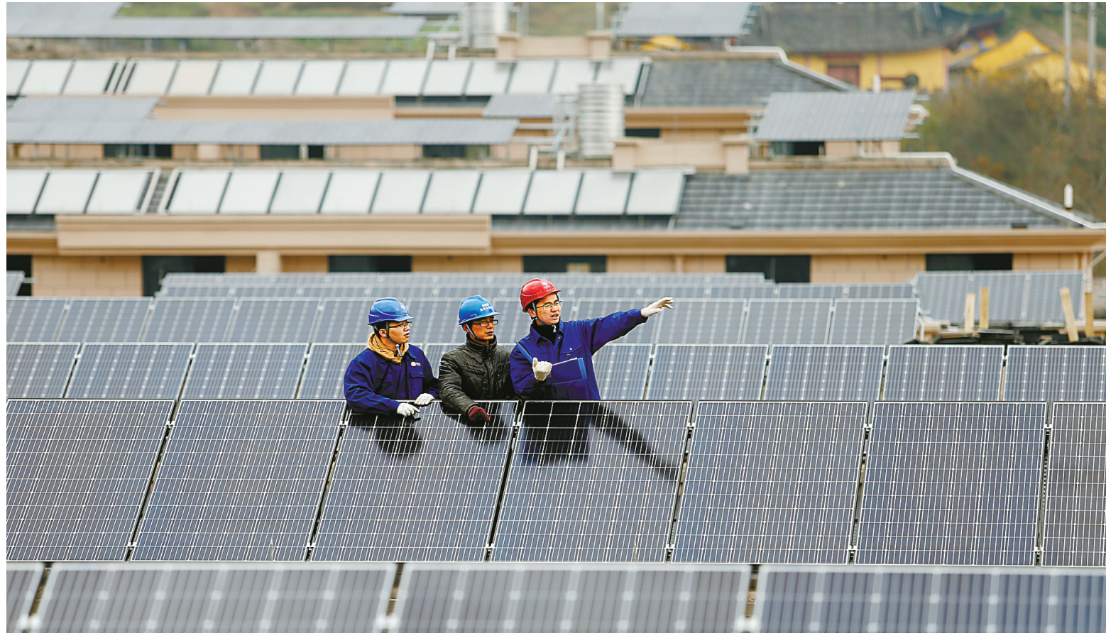
电力工人对屋顶光伏项目进行验收。
