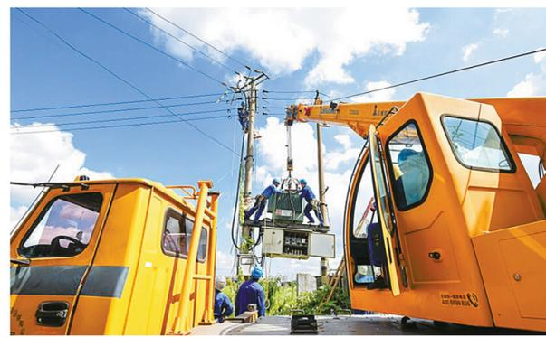
昨天上午,在江北区康庄南路旁,宁波甬城配电网公司职工正在进行变压器拆除作业,抓紧时间开展庄桥中心开关站位移工程。为有效提高该地区供电可靠性,国网宁波供电公司根据部署规划,将庄桥中心开关站迁移,并新建多个环网站,实现该地区供电网络“手拉手”供电效应。
