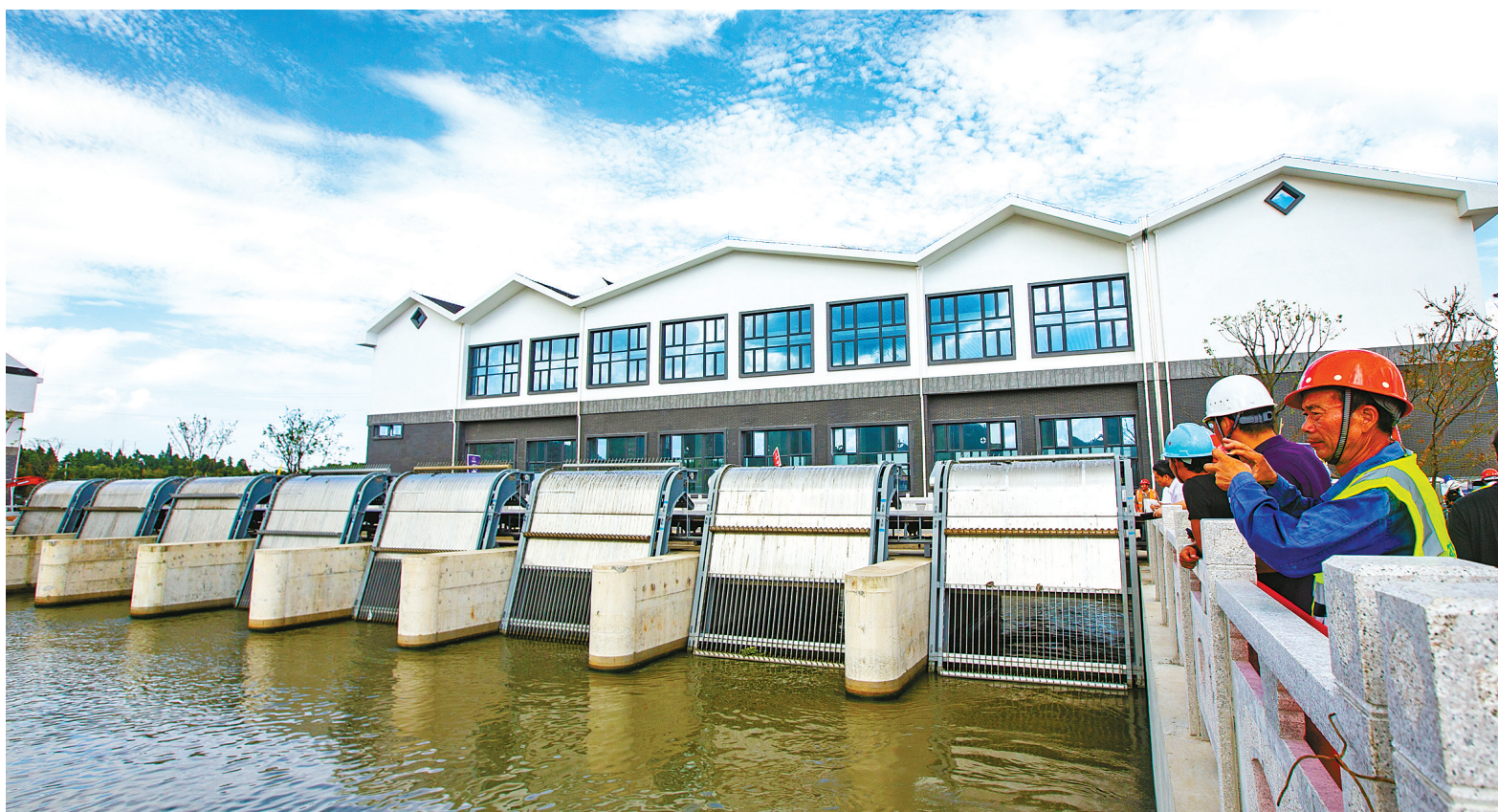
昨天, 化子闸泵站成功启动, 姚江二通道(慈江)实现全线通水。
