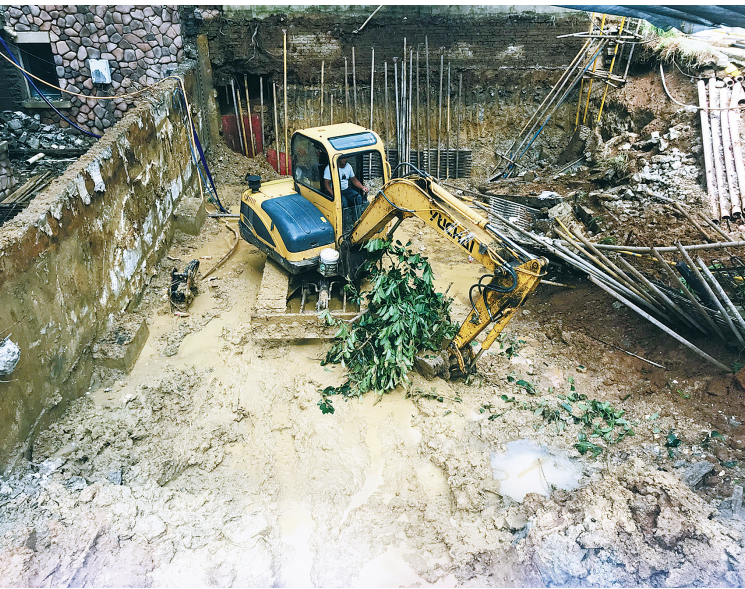
20幢别墅南侧院子里深约3米的大坑。
