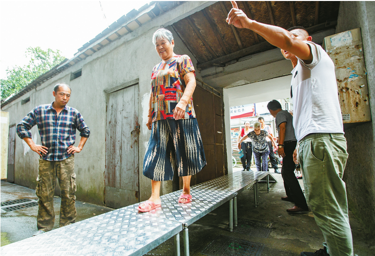
昨天早上，海曙区南门街道马园社区在往年台风季容易积水的楼道搭建便民桥。这种简便的桥长8米，拆解折叠后只有1米长，高度可调，非常灵活方便，是社区特意设计定制的。
