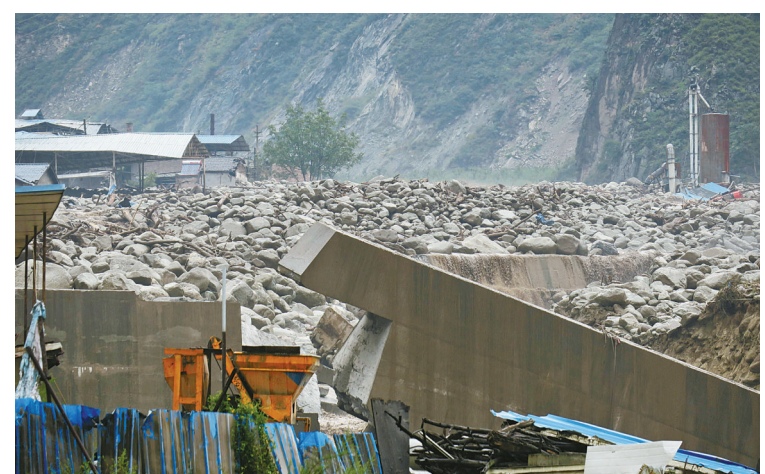
8月20日拍摄的汶川县板桥村泥石流灾害现场。（新华社发）
