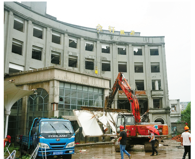
图为破拆现场。(王岚 沈默 摄)
