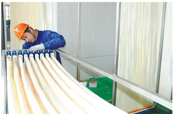
江东水厂采用全国领先的膜处理制水工艺。图为工人在安装超滤膜。（宁波市供排水集团供图）
