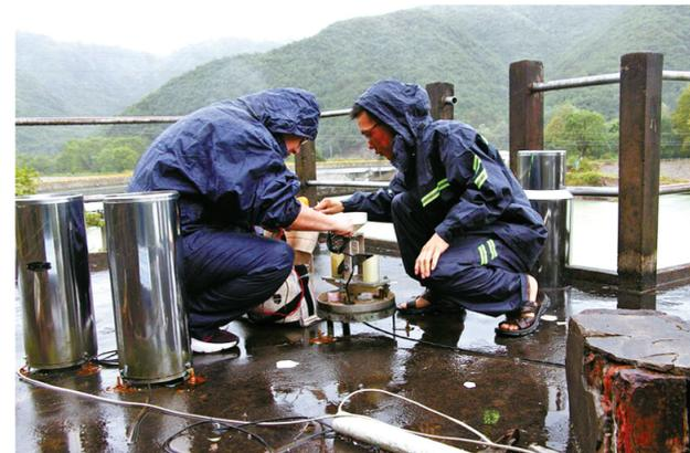
昨天早上，白溪水库风越刮越猛，雨越下越大。得知白溪水库兆岸水文站的雨量计出现故障后，抢修人员丁红波、谢敏辉冒雨赶到现场。在疾风骤雨中，他俩人更换配件，一人检测设备，等雨量计修好后浑身都湿透了。据悉，水文站是水库观测降雨量的“眼睛”，而雨量计则是其最重要的组成部分“眼角膜”。（任宓娜 王博 摄）
