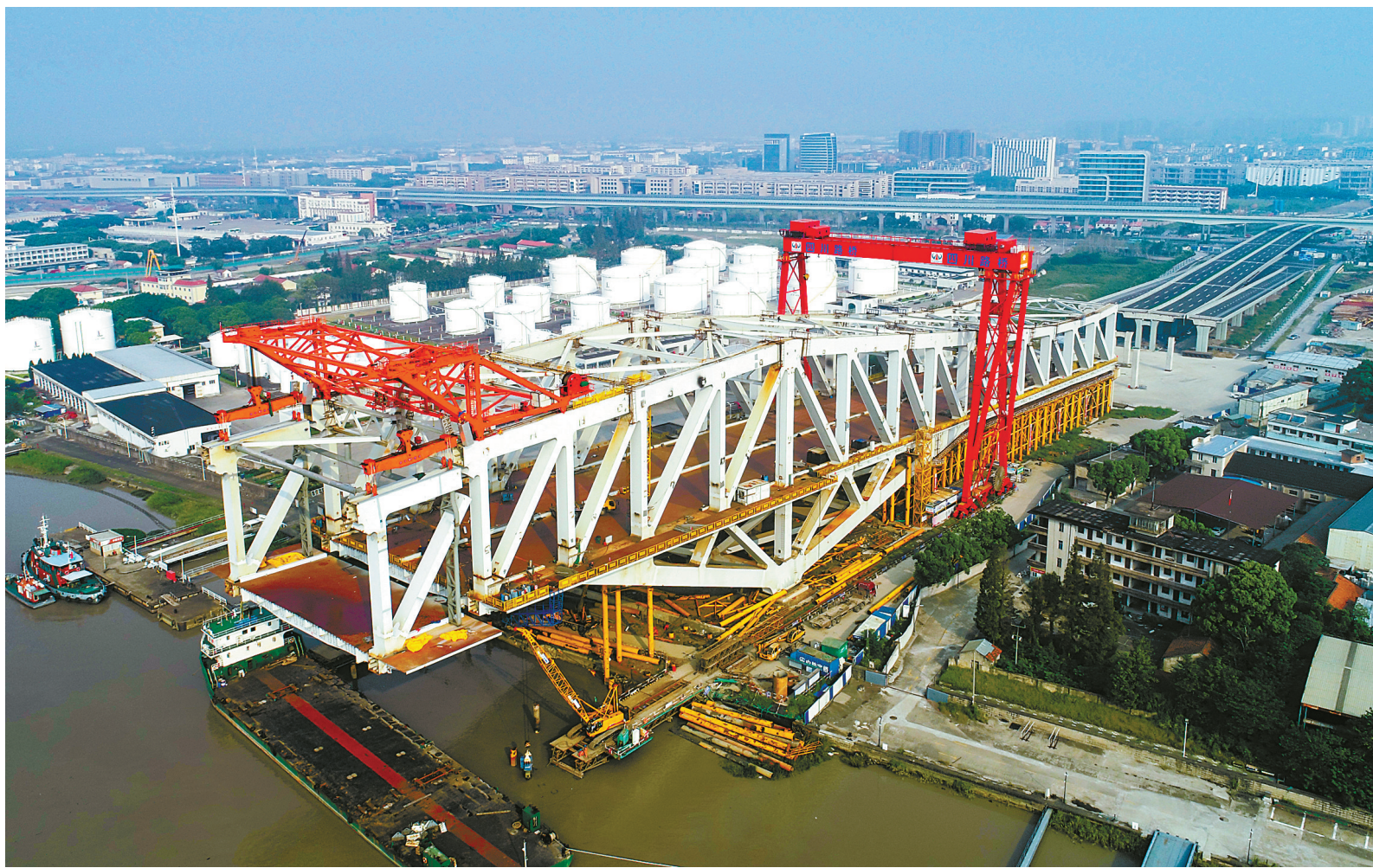
自9月25日起,横跨甬江的又一座南北大通道——三官堂大桥进入中跨大节段钢桁梁施工阶段,为实明明年9月工程具备通车条件奠定了基础。三官堂大桥及接线工程南起江南路,北至中官西路,全长约3.3公里,道路标准断面宽度68米,为城市主干道,其中,跨越甬江的节点工程采用主跨465米的连续体系钢桁梁。该桥主桥全部采用钢结构,总重量达3.6万吨。(周思聪 杨绪忠 摄)
