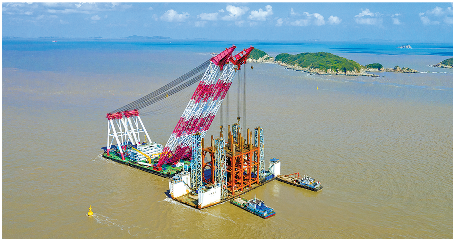
图为舟山潮流能发电示范工程平台吊装现场。(王马飞 王森 摄)
