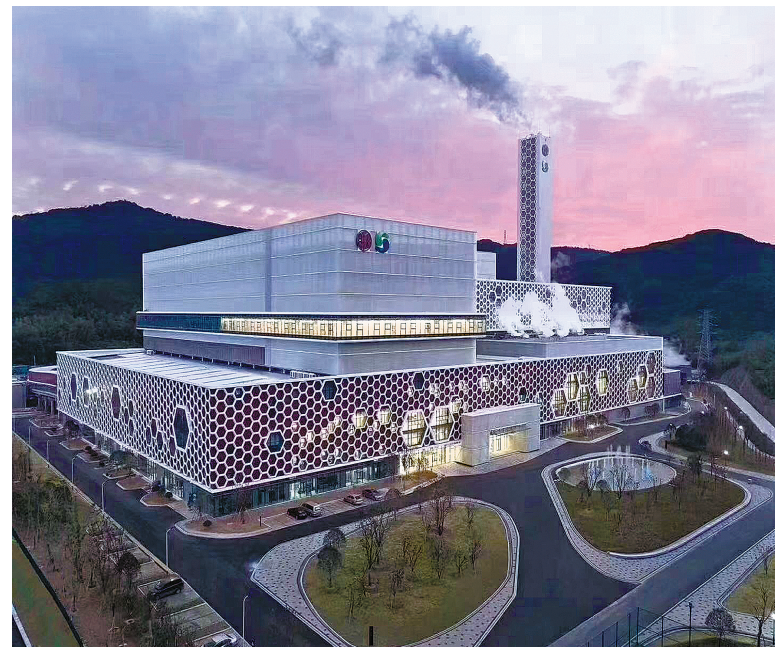
宁波市洞桥生活垃圾焚烧发电厂全景。
