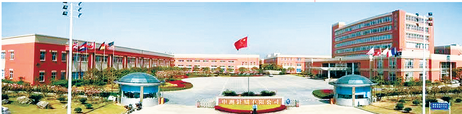
中洲集团借助宁波市土地二级市场平台,通过司法拍卖处置、企业并购转让、边角地零星利用等方式,盘活原宏泰化纤、紫泉饮料、恒达电器等低效土地100余亩,现正进行改建施工。
