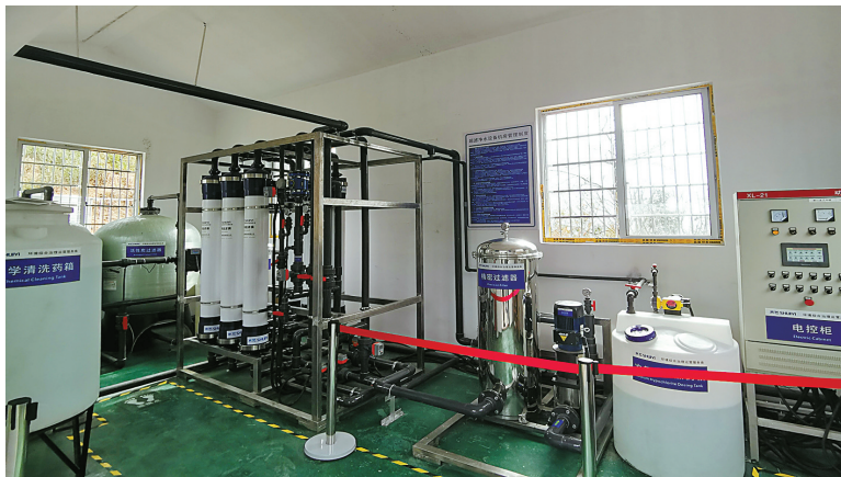
奉化溪口镇兰峰村供水站内部先进的膜处理设备
