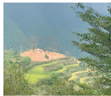
梅竹村山顶正在建缆车。
