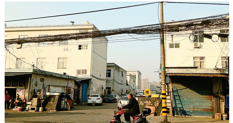
毛家漕工业区门口已无电线垂地。
