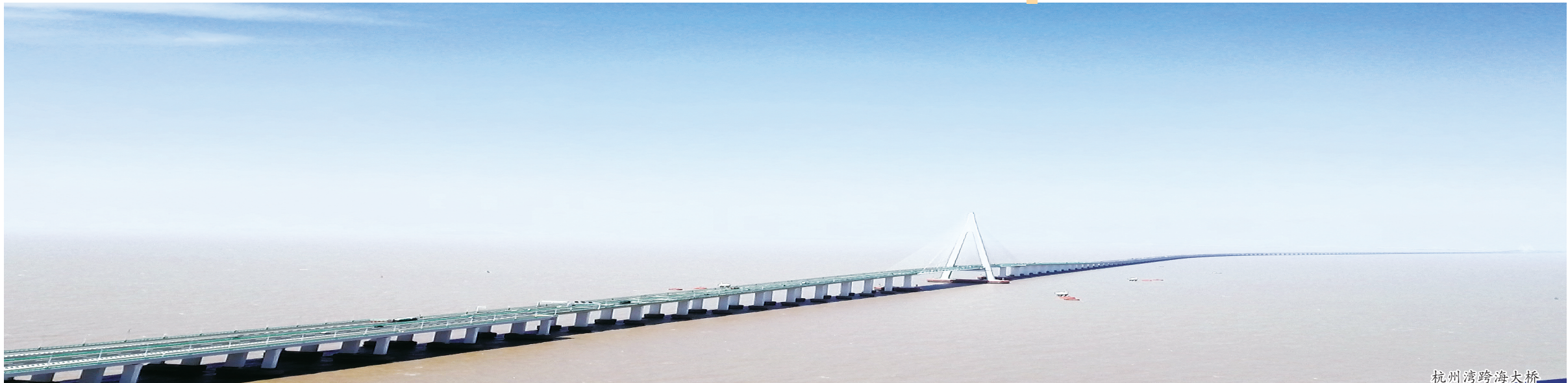
杭州湾跨海大桥
