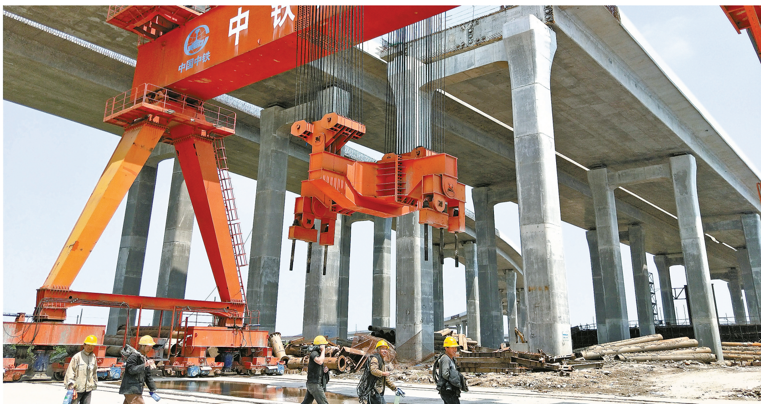
项目建设工地
