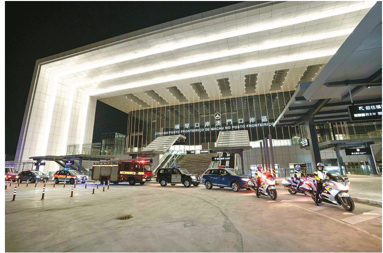
3月18日拍摄的横琴口岸澳方口岸区。
