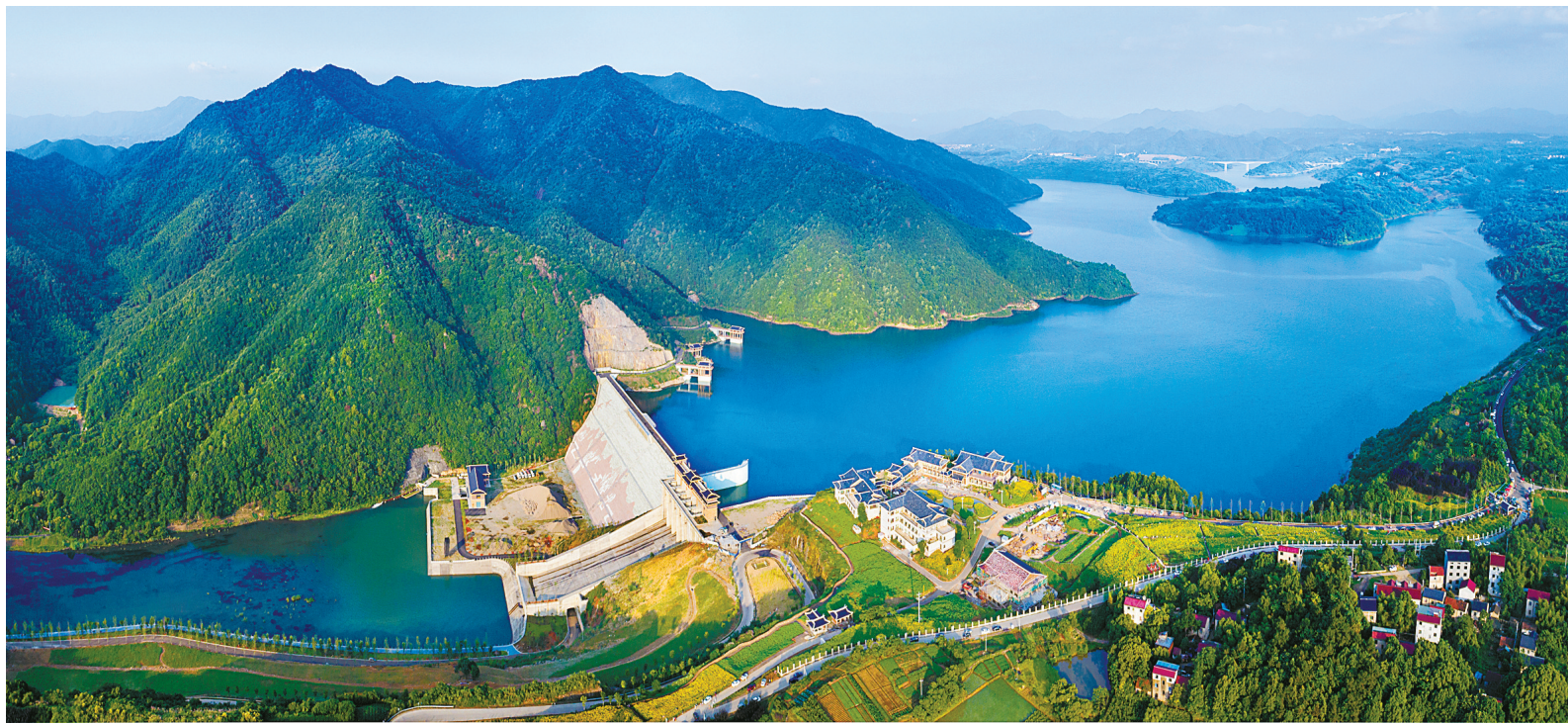
图为水库群联网联调(西线)一期工程重要“节点”钦寸水库(资料图片)。
