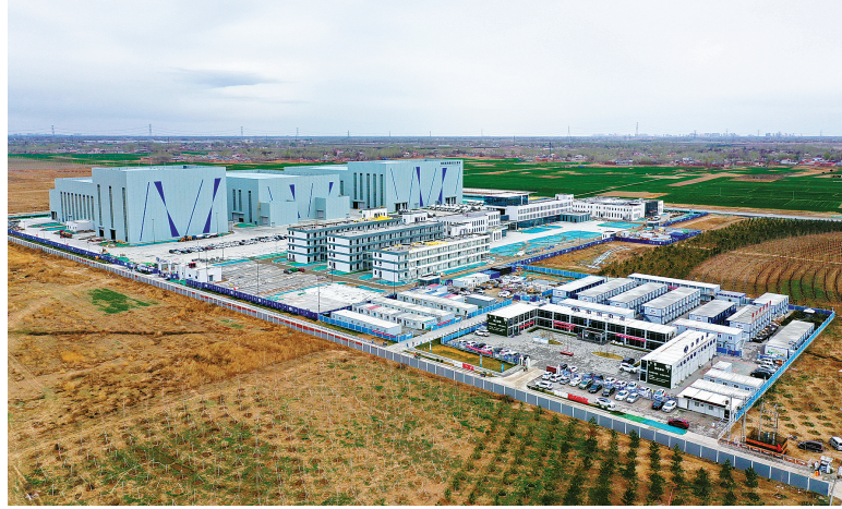
这是3月26日拍摄的雄安新区容西混凝土搅拌站（无人机照片）。雄安新区多项重点项目建设有序推进，正向着高质量发展的“未来之城”稳步迈进。（新华社记者 杨世尧 摄）
