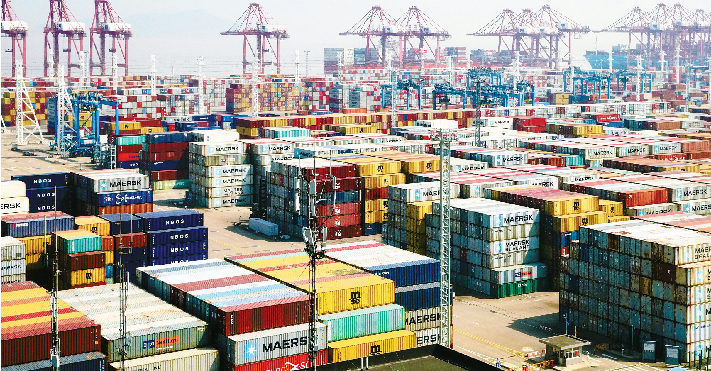
宁波舟山港穿山港区集装箱码头。(王鹏 摄)
