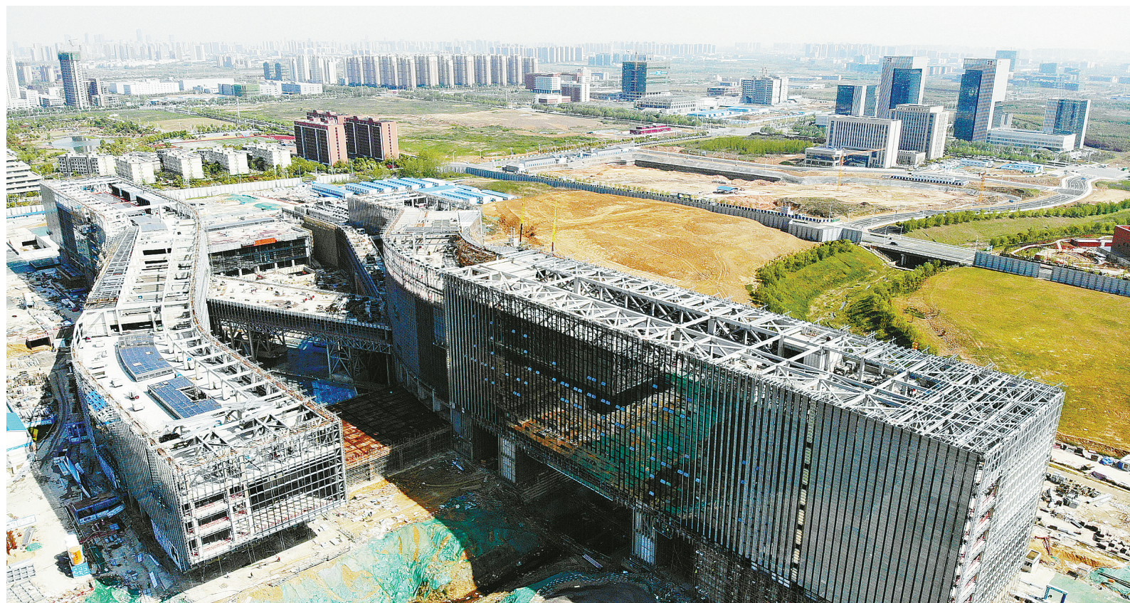
这是4月13日拍摄的中科院量子信息与量子科技创新研究院施工现场（无人机照片）。
