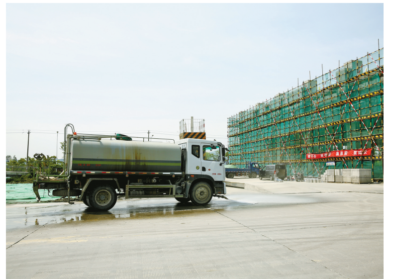
洒水车给工地路面洒水降尘。
