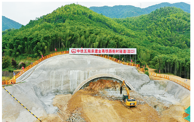
金甬铁路第二长隧道——鲍村隧道开工建设。（记者 唐严 摄）
