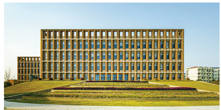
《真诚图书馆》（庞升东捐资，2017年1月竣工）
