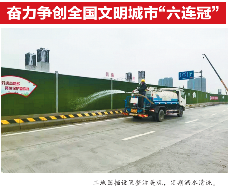
工地围挡设置整洁美观，定期洒水清洗。
