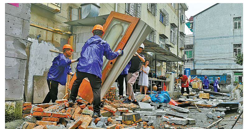
图为拆除违建现场。（陈朝霞 徐浩跃 摄）
