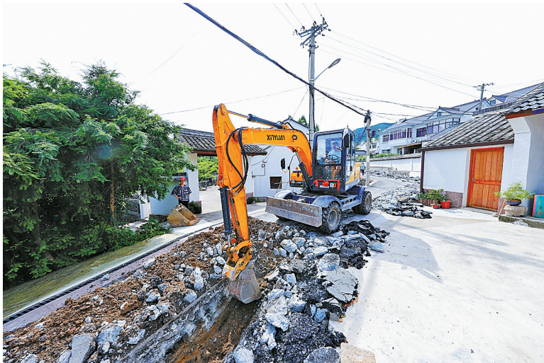
毛岙村启动自来水管铺设。
