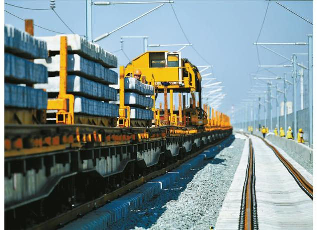
6月18日，中铁一局新运公司施工人员在银西高铁陕西西安段进行铺轨作业。当日，由中铁一局新运公司承建的银西高铁陕西段铺轨工程顺利完工，为下一步线路静态验收奠定基础。银川至西安高速铁路是国家中长期铁路网规划中“八纵八横”高铁网的重要组成部分，是连接关中城市群和宁夏银川的便捷通道，预计2020年底开通。(新华社记者 张博文 摄)
