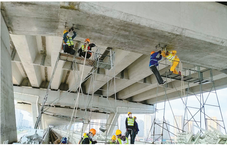
高架下的轨道交通建设。
