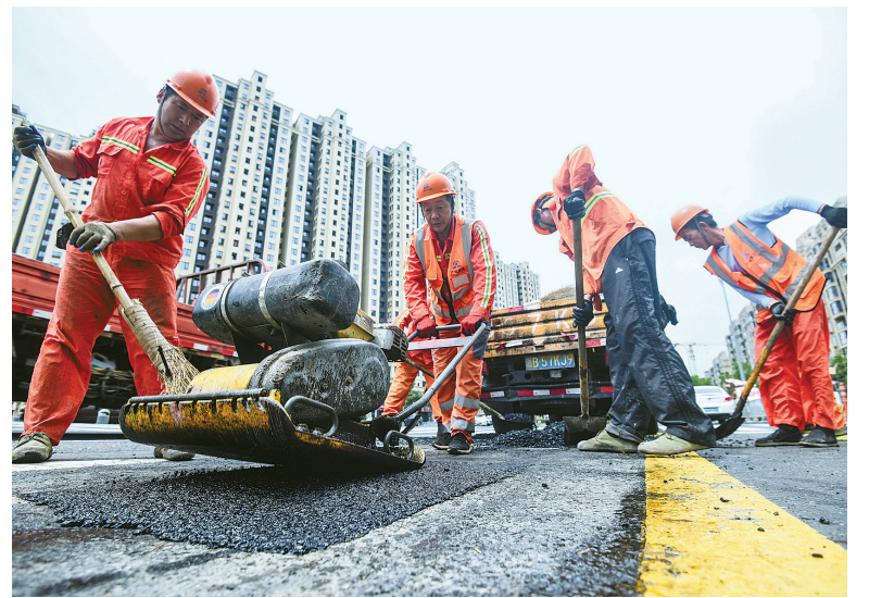
连续强降雨致明光路、广德湖路、鄞州大道等路段受损严重，路面坑槽较多。从6月22日开始，鄞州区市政设施保障中心安排3班机动车巡查班组，轮流上路巡查，保障路面安全畅通。截至目前已修复坑洞224处，面积450平方米。图为昨日上午，养护工人正在王隘南路与建兴西路交叉口修补破损路面。（徐能 曹百灵 摄）
