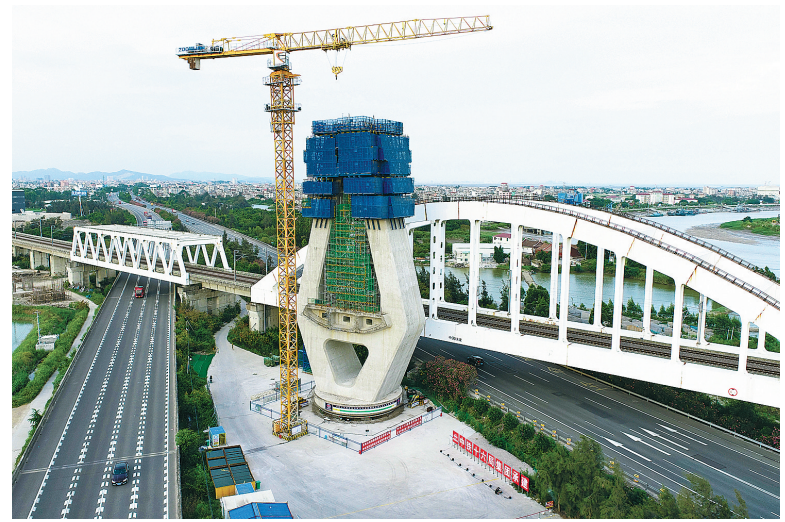
7月7日拍摄的木兰溪特大桥万吨主塔。（新华社发）
