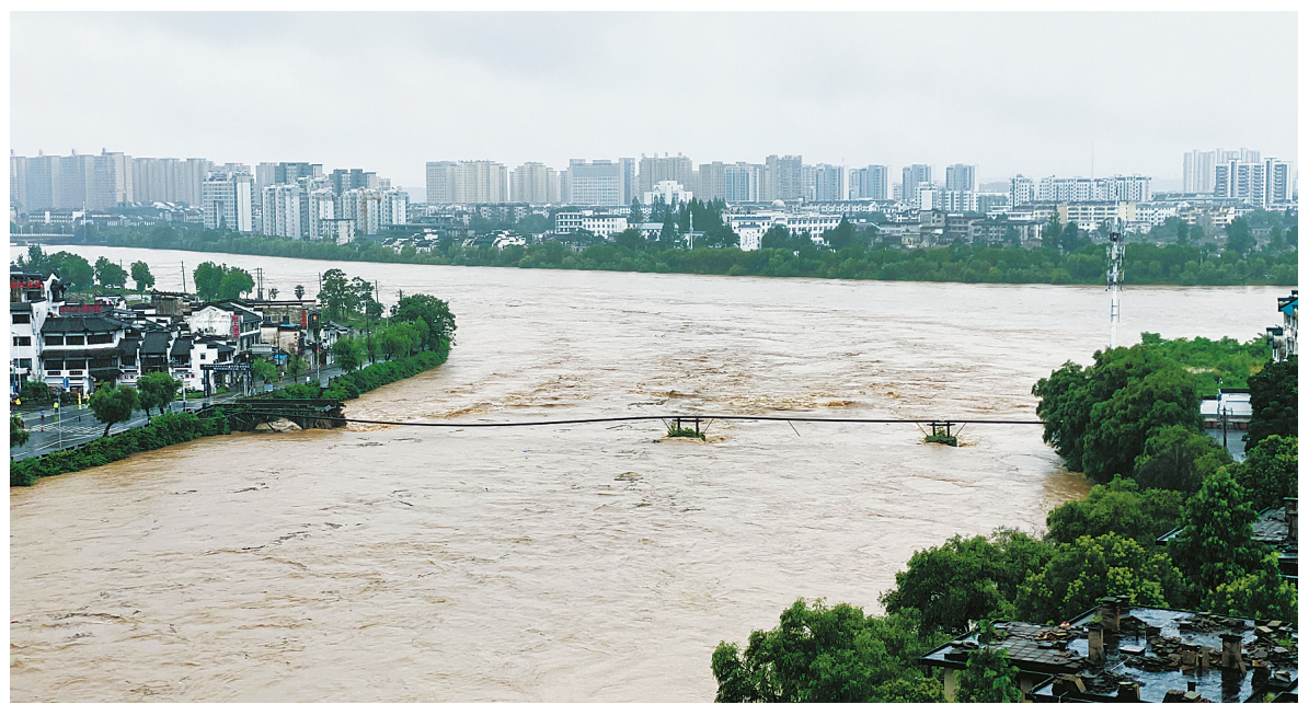
7月7日上午，安徽黄山屯溪老大桥被洪水冲垮毁坏。屯溪老大桥又叫镇海桥，始建于明代。（新华社发）
