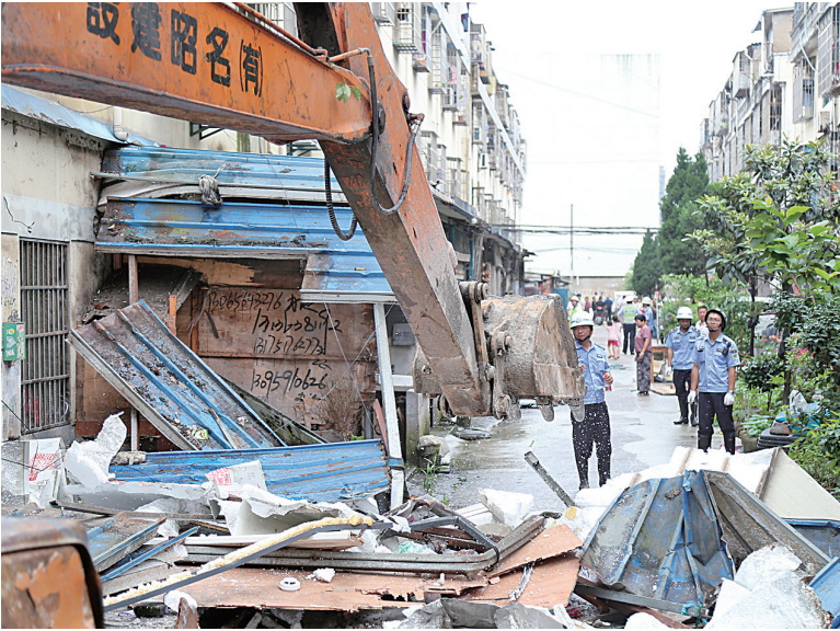
高桥镇“拆违治乱”环境整治行动现场。
