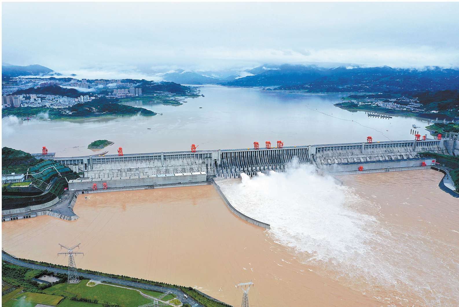
7月18日，三峡枢纽开启泄洪深孔泄洪（无人机照片）。受强降雨影响，“长江2020年第2号洪水”于17日在长江上游形成，三峡水库入库流量快速上涨，18日8时达6.1万立方米/秒。这是今年入汛以来抵达三峡的最大洪水。洪水抵达时，三峡枢纽安全平稳运行。（新华社发）
