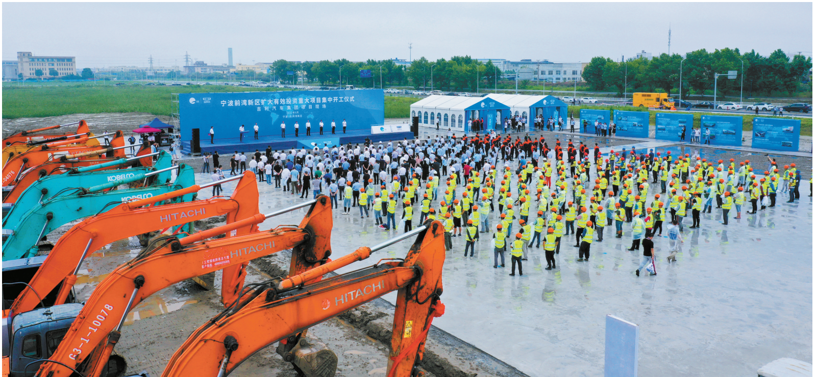
前湾新区扩大有效投资重大项目集中开工
