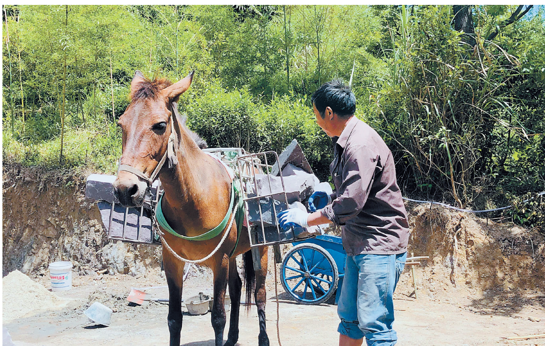
赤水供水站施工现场。
