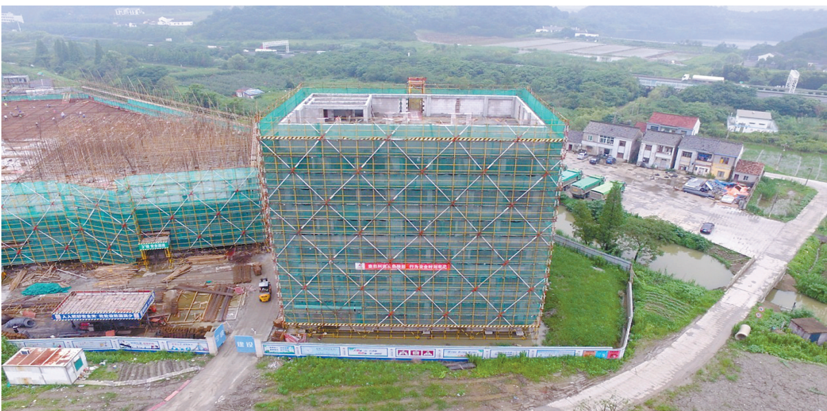
江北工业区建设现场。
